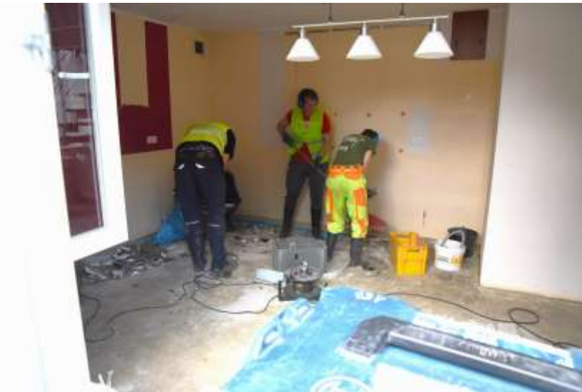
Freiwilliger Helfer, hier von den Dachzeltnomaden, helfen dabei, vom Hochwasser durchtränkte Estriche aus einem Haus heraus zu stemmen. (Foto: ADRA Deutschland e.V. Andreas Lerg)
